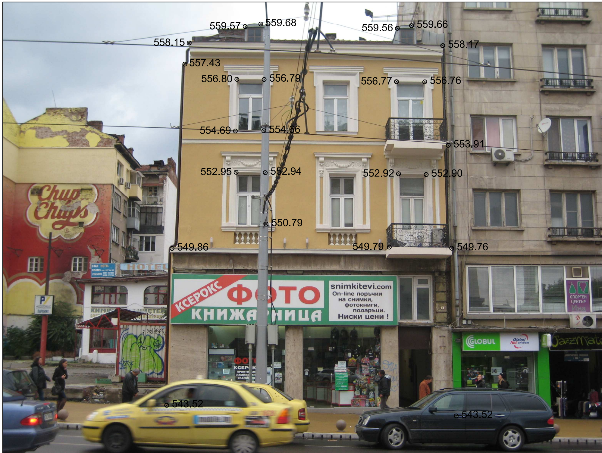
Сграда N 6 - източна фасада
