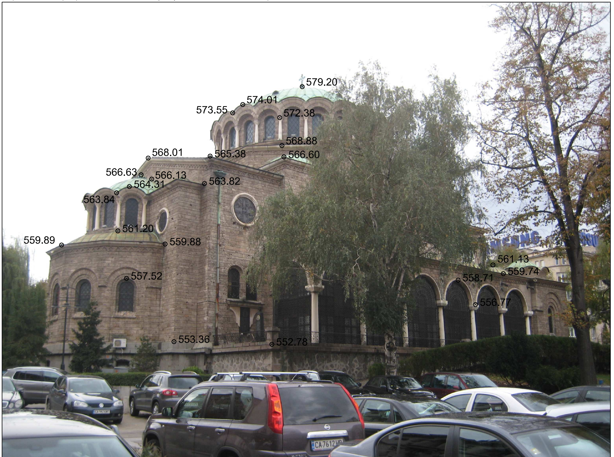
Сграда No 9 (църква "Св. Неделя") - фасади: изток и север
