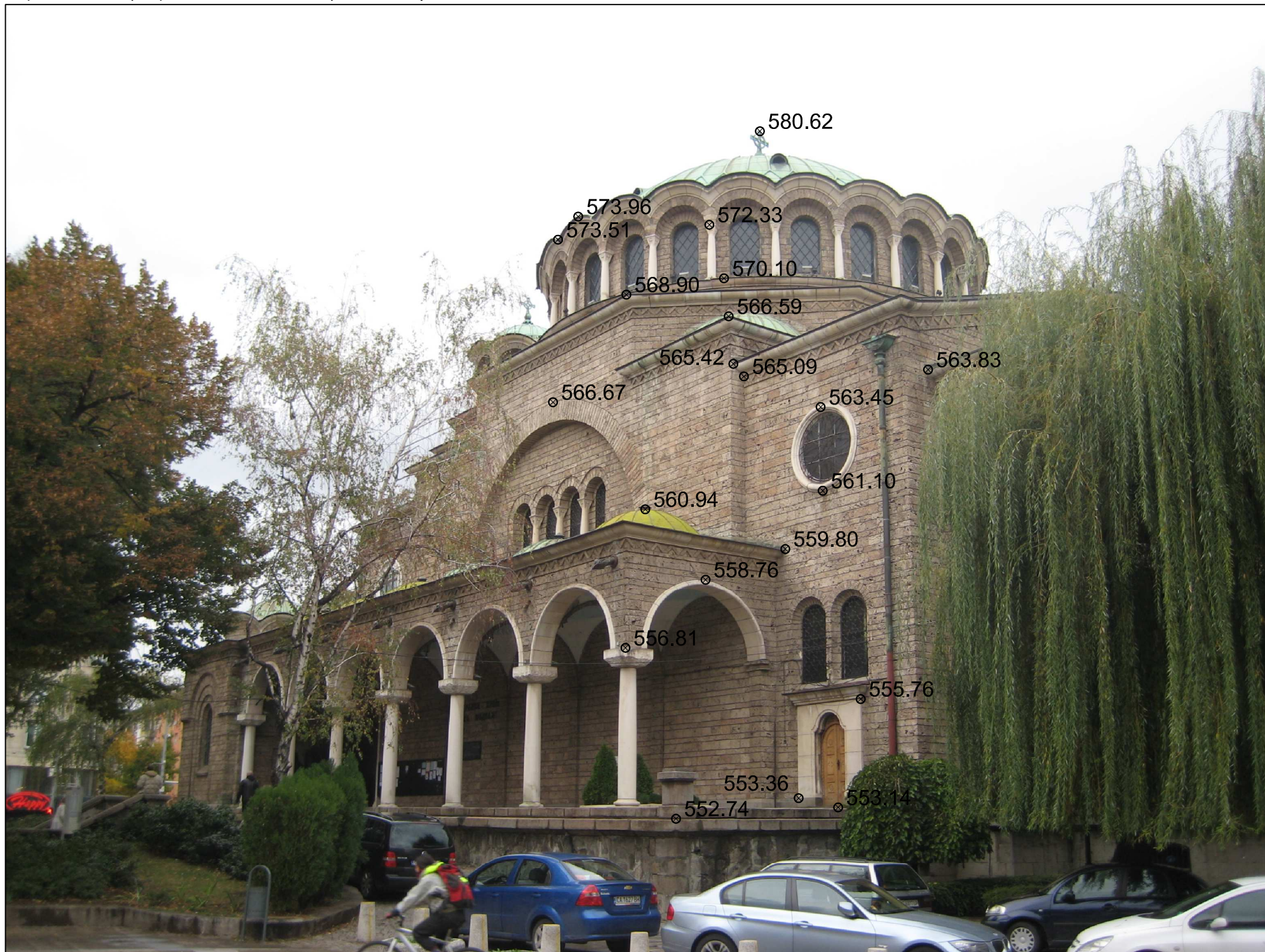
Сграда No 9 (църква "Св. Неделя") - южна фасада
